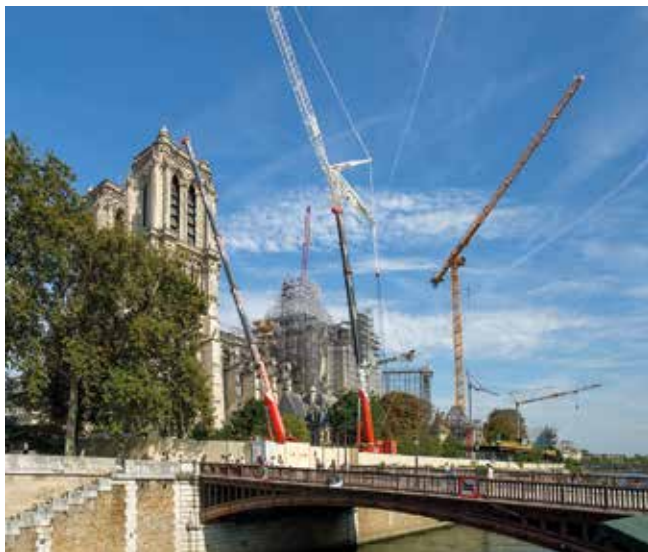
Notre-Dame de Paris klädd i byggnadsställningar under det omfattande restaureringsarbetet.
