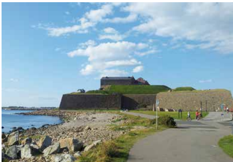
Varbergs fästning där man hittat mynt från 1500-, 1600- och 1700-talen.
