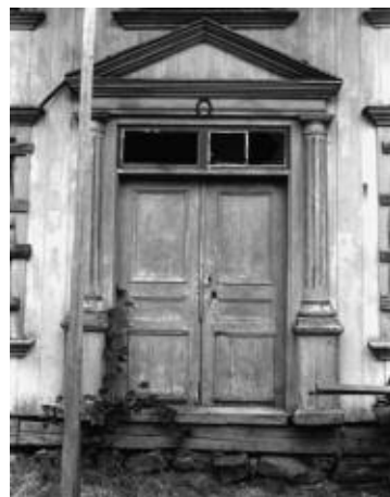
2. Portalen med doriska halvkolonner. På bilden syns sällstocken under tröskeln, där det vid renoveringsarbetet skulle visa sig ligga ett mynt. Foto i september 1979: Carina Holmgren, Västerbottens museum.
