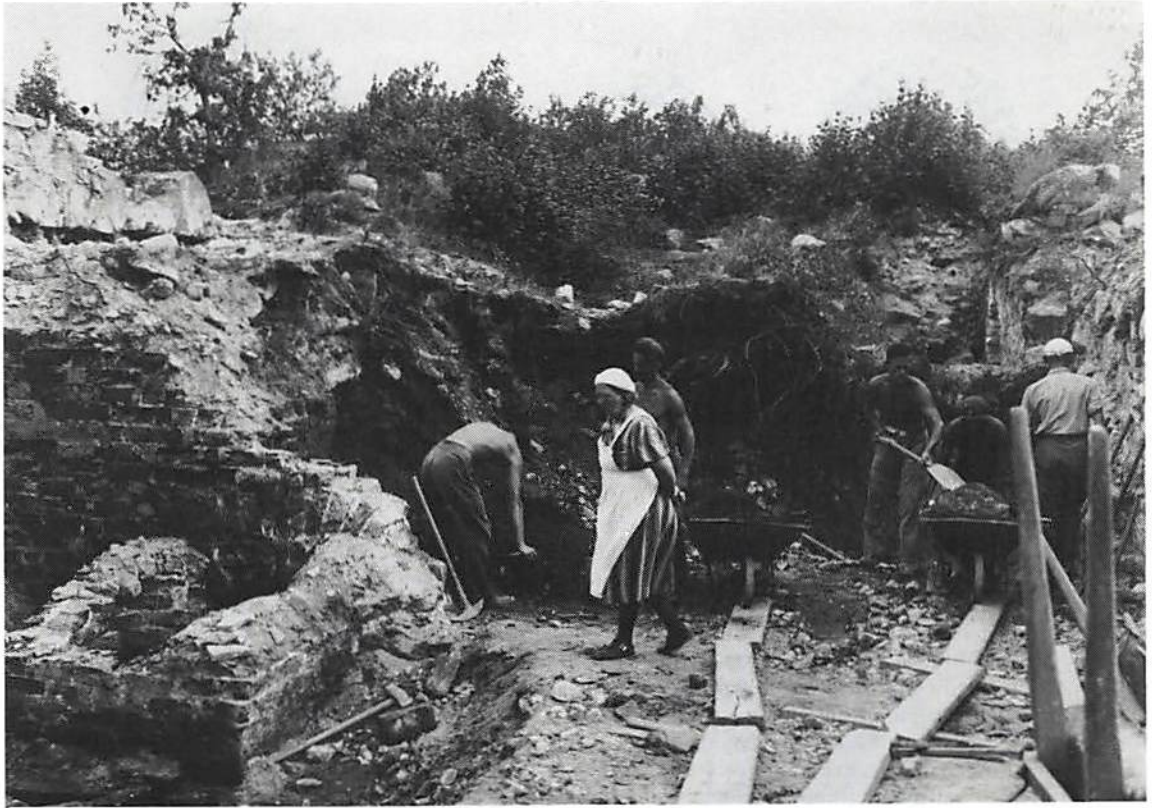
Fig 2. Arbetsbild från undersökningen 1939. Foto E B Lundberg. ATA 66:91.
